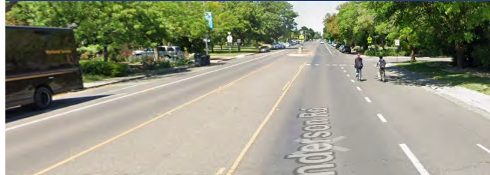
Colector con Ciclovía (Anderson)
